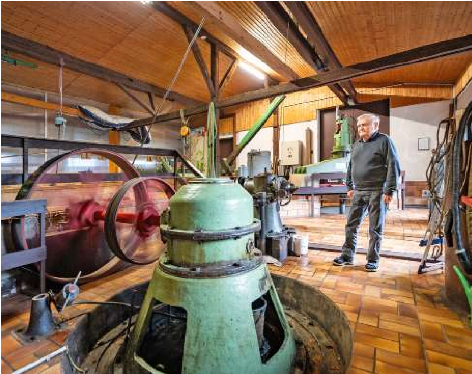
Im Maschinenraum erzeugen zwei Generatoren grünen Strom. Unter Hilmar Oppels Füßen fließt das Wasser der Itz durch die beiden Turbinen.
