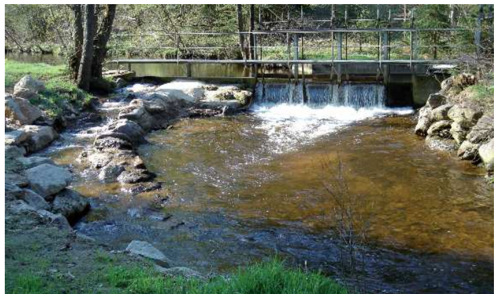
Die Fischtreppe des Kraftwerks Rümleinsäge an der Großen Ohe in Spiegelau: Immer mehr Betreiber legen solche Umgehungen an, um Fischen das Wandern zu ermöglichen.
