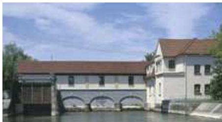
Die Wasserkraft könnte nach den Vorstellungen der Staatsregierung noch ausgebaut werden; hier ein Kraftwerk an der Amper in Schöngesing (Bild: Stadtwerke Fürstenfeldbruck)
